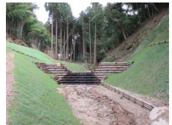
木製治山ダム
